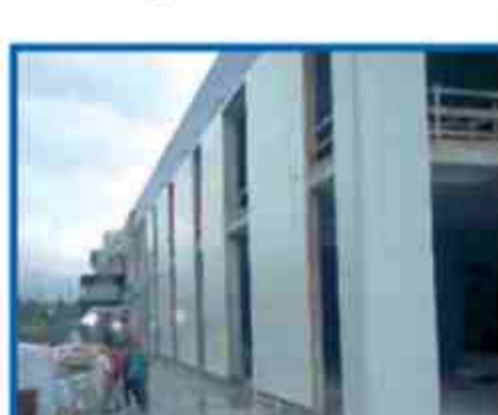
Stabilimento farmaceutico KEDRION Bologna (LU) Nuovo edificio emodermatologici Committente: Inso SpA Firenze
