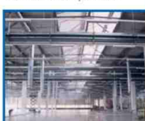
Nuovo Stabilimento BOSCH Bari Committente: Miter srl Bari Jacorossi SpA Milano
