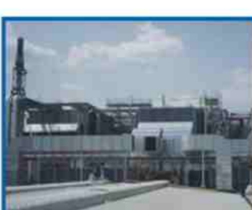
Stab. NYLSTAR SERVIZI SpA - SNIA Pisticci Scalo - Matera Committente: MAZZINI ICI SpA / SNIA
